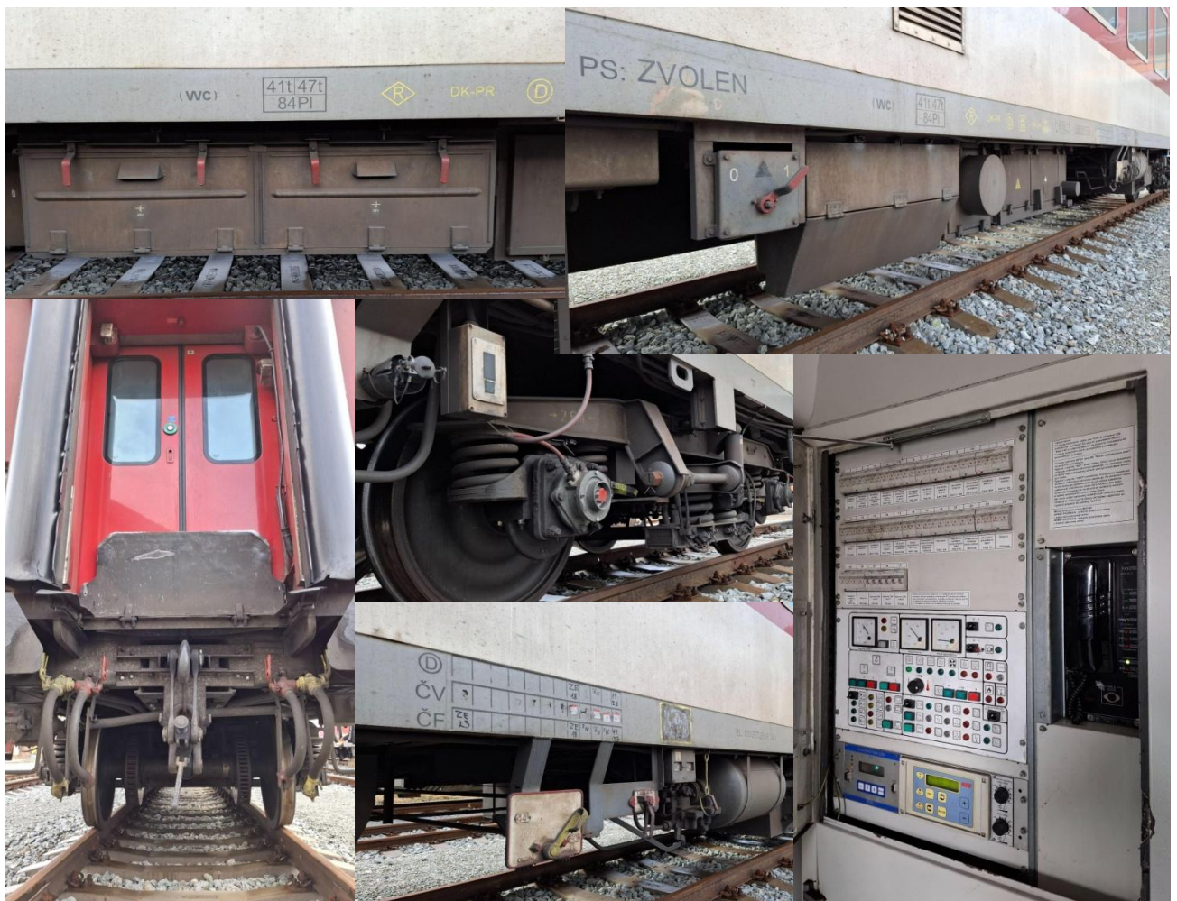
Obr. č. 11 Pohľad na zastaralé riešenie neuzatvorených skríň
